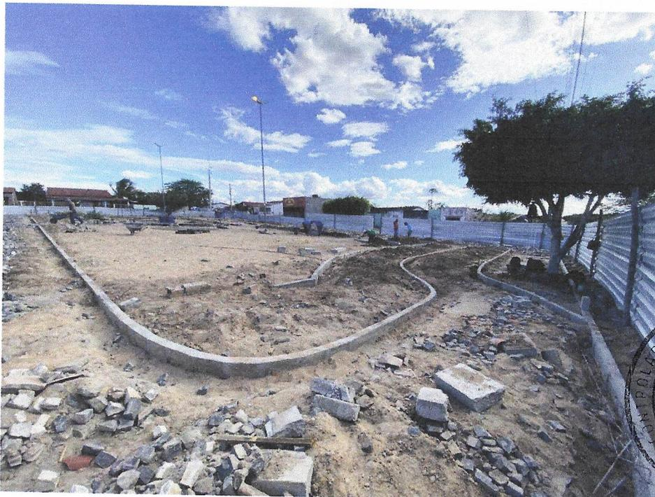
Foto 12 - ASSENTAMENTO DE GUIA (MEIO-FIO) EM TRECHO CURVO, CONFECCIONADA EM CONCRETO PRÉ-FABRICADO, DIMENSÕES 100X15X13X20 CM (COMPRIMENTO X BASE INFERIOR X BASE SUPERIOR X ALTURA), PARA URBANIZAÇÃO INTERNA DE EMPREENDIMENTOS. AF\_06/2016\_P
