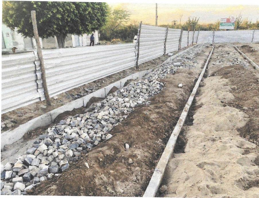
Foto 11 - ASSENTAMENTO DE GUIA (MEIO-FIO) EM TRECHO RETO, CONFECCIONADA EM CONCRETO PRÉ-FABRICADO, DIMENSÕES 100X15X13X20 CM (COMPRIMENTO X BASE INFERIOR X BASE SUPERIOR X ALTURA), PARA URBANIZAÇÃO INTERNA DE EMPREENDIMENTOS. AF\_06/2016\_P
