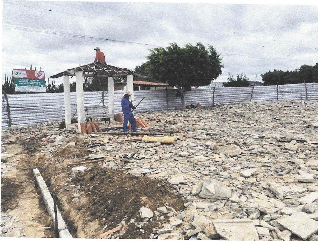
Foto 05- Demolição de concreto manualmente
