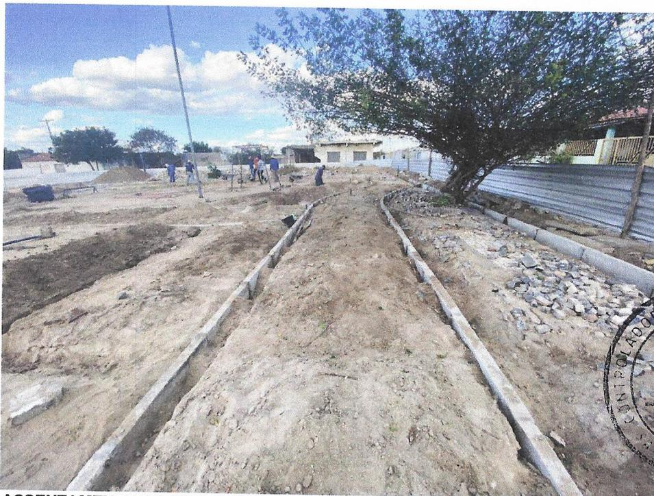
Foto 14 - ASSENTAMENTO DE GUIA (MEIO-FIO) EM TRECHO RETO, CONFECCIONADA EM CONCRETO PRÉ-FABRICADO, DIMENSÕES 80X08X08X25 CM (COMPRIMENTO X BASE INFERIOR X BASE SUPERIOR X ALTURA), PARA URBANIZAÇÃO INTERNA DE EMPREENDIMENTOS. AF\_06/2016
