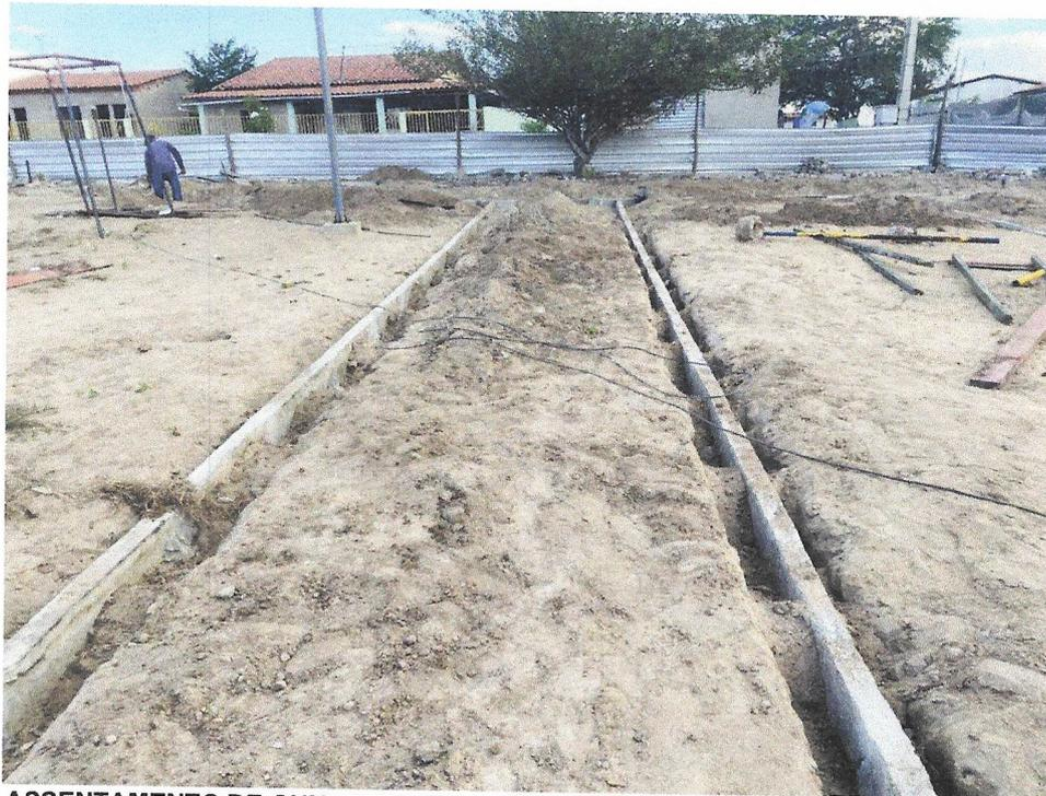
Foto 13 - ASSENTAMENTO DE GUIA (MEIO-FIO) EM TRECHO RETO, CONFECCIONADA EM CONCRETO PRÉ-FABRICADO, DIMENSÕES 80X08X08X25 CM (COMPRIMENTO X BASE INFERIOR X BASE SUPERIOR X ALTURA), PARA URBANIZAÇÃO INTERNA DE EMPREENDIMENTOS. AF\_06/2016
