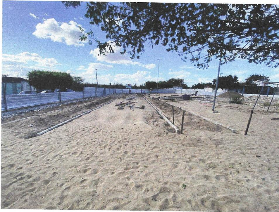
**Foto 09 - ATERRO MANUAL COM SOLO ARGILLO-ARENOSO IMPORTADO E COMPACTAÇÃO MECANIZADA EM CAMADAS DE 0,20 M NO MÁXIMO**
